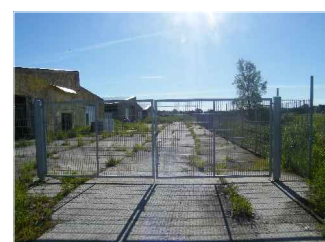
Foto 1: versiegelte Nebenflächen, südlich Bestandshallen
