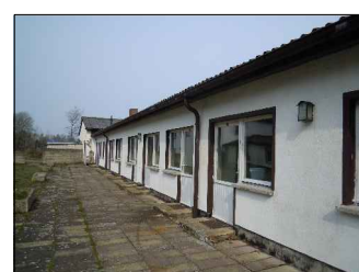
② südlicher Terrassenbereich des zentralen Ferienwohngebäudes
